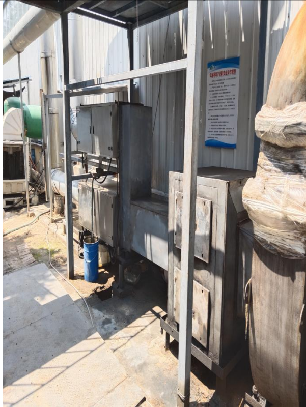
1#油烟净化低温等离子装置+1#活性炭吸附装置
