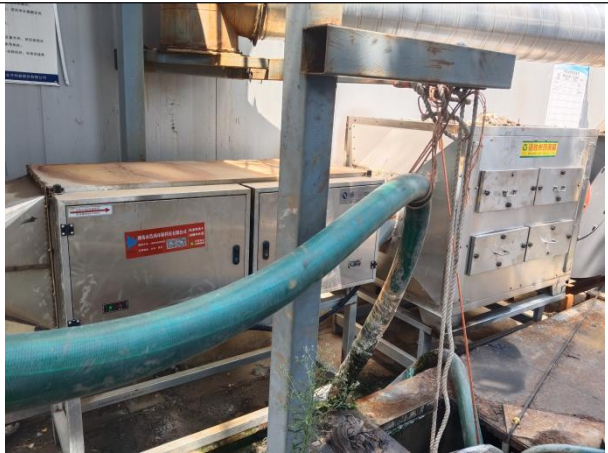
2#油烟净化低温等离子装置+2#活性炭吸附装置
